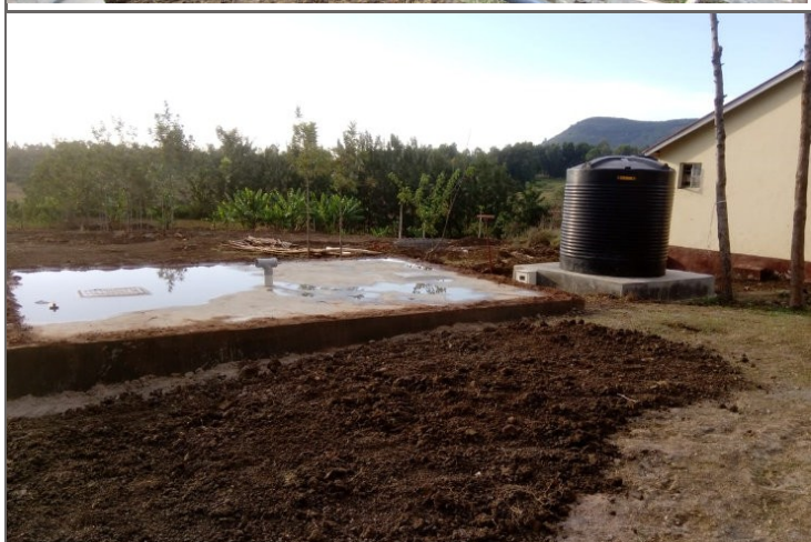
De afwerkte watertank met pomptank op de achtergrond
