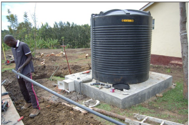
De pomptank op betonnen sokkel en voorbereiding van de distributieleidingen.
