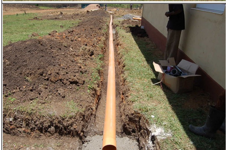
Aanleg van het rioleringsstelsel om het regenwater van alle gebouwen naar de watertank te voeren.
